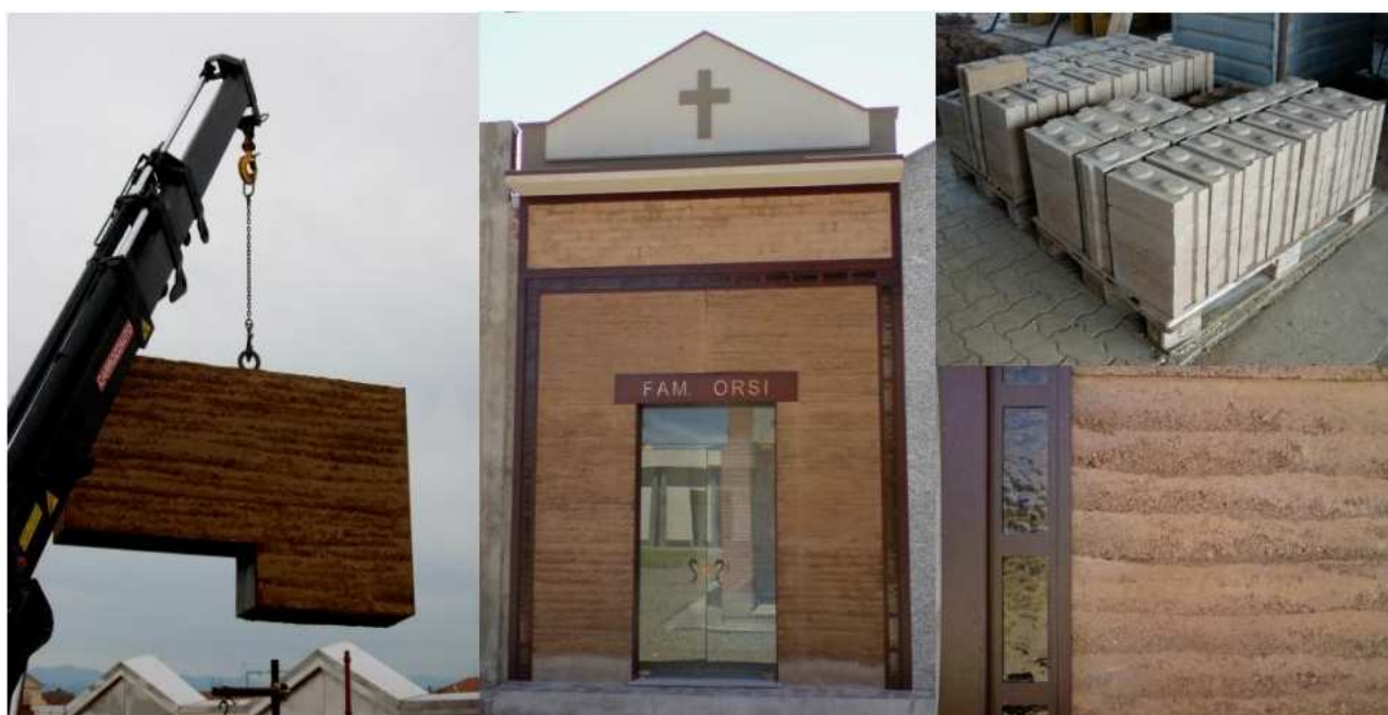
PARTICOLARE A DISPOSIZIONE BLOCCHI IN TERRA CRUDA STABILIZZATA
