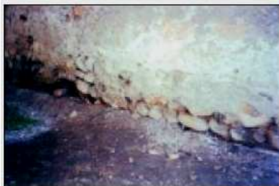
Fondazioni di un muro in terra prima dell'intervento di restauro.
