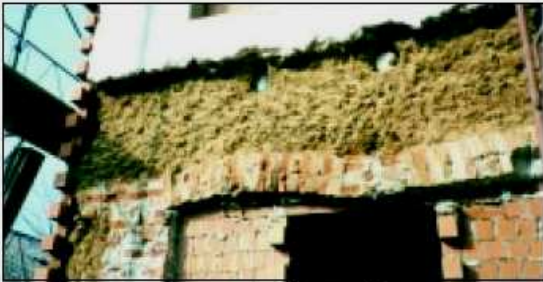
Fase prima: asportazione di uno strato superficiale della muratura in terra battuta.
