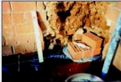
Fase seconda: innalzamento della cortina muraria in laterizi.
