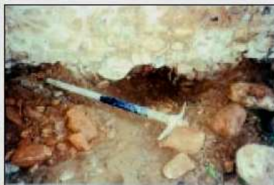
Prima fase: rimozione dei ciottoli di fondazione attraverso scavi alterni di 100 cm lungo tutta la muratura.
