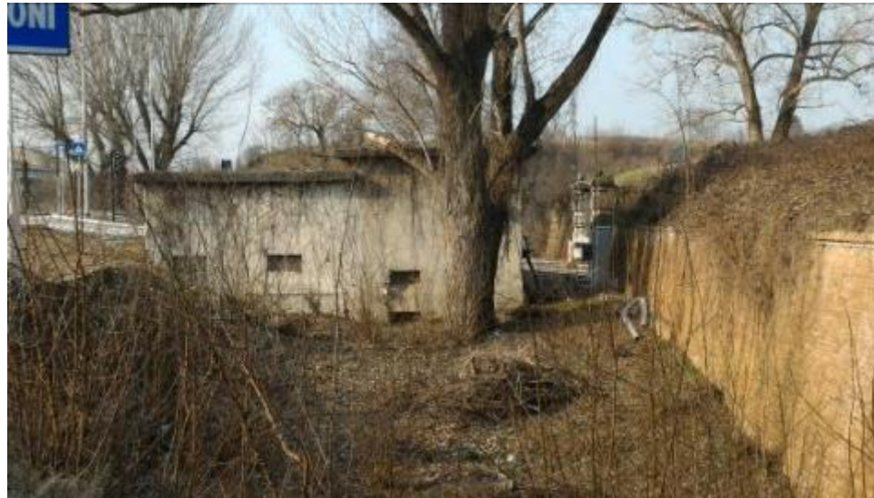
Cabina Elettrica esistente presso ingresso su Via Pavia
