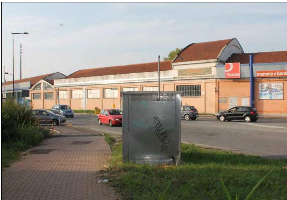
*Armadiatura contenente le apparecchiature di intercettazione e controllo della tubazione del gas metano in media pressione*
