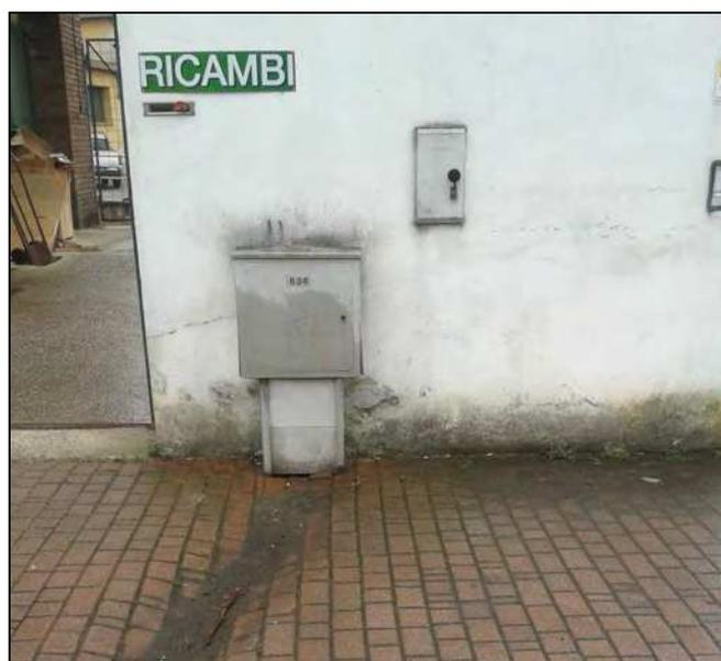
*Colonnina di consegna energia elettrica B.T. al Consorzio Agrario e sportello per contatore in nicchia murata (ENEL), lungo il muro perimetrale su Via Vecchia Torino*
