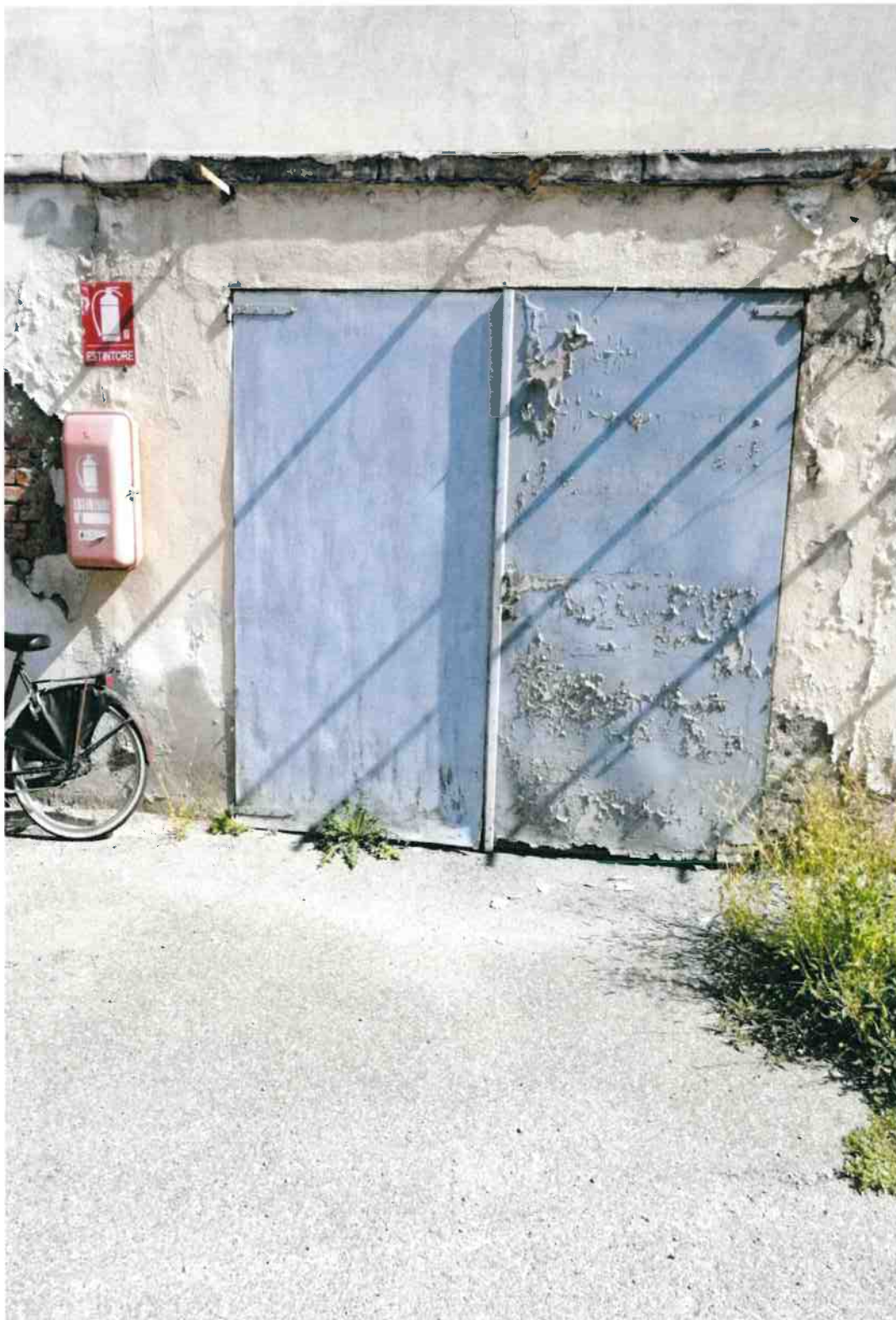
FOTO PORTA DI ACCESSO BOX LOTTO 1
