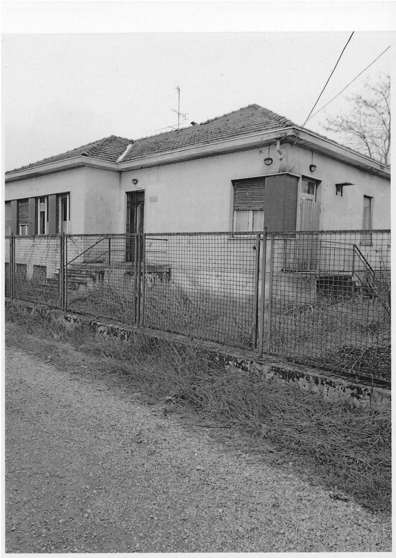
FOTO LOTTO FABBRICATO N. 8
