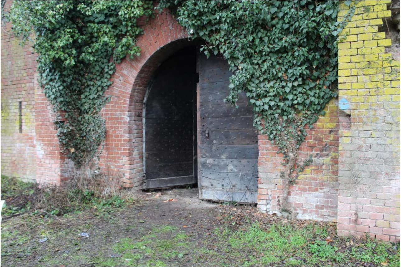
Modello di portone esistente di fortino che potrà essere adottato come modello per il ripristino delle chiusure non più esistenti
