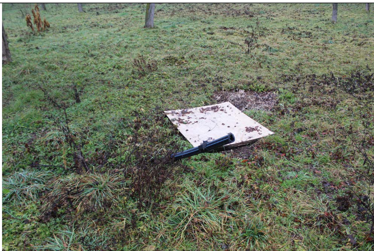
Botola rete idrica / impianto elettrico
