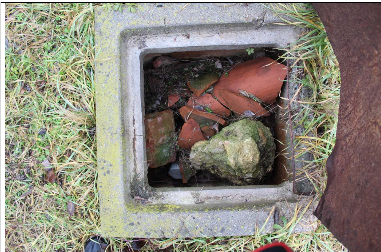
Chiusino rete elettrica / idraulica rilevato sul camminamento perimetrale
