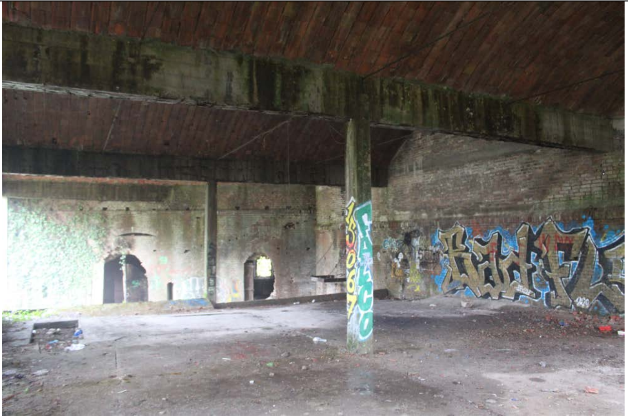
Dettaglio interno fortino in zona ingresso al Forte Acqui
