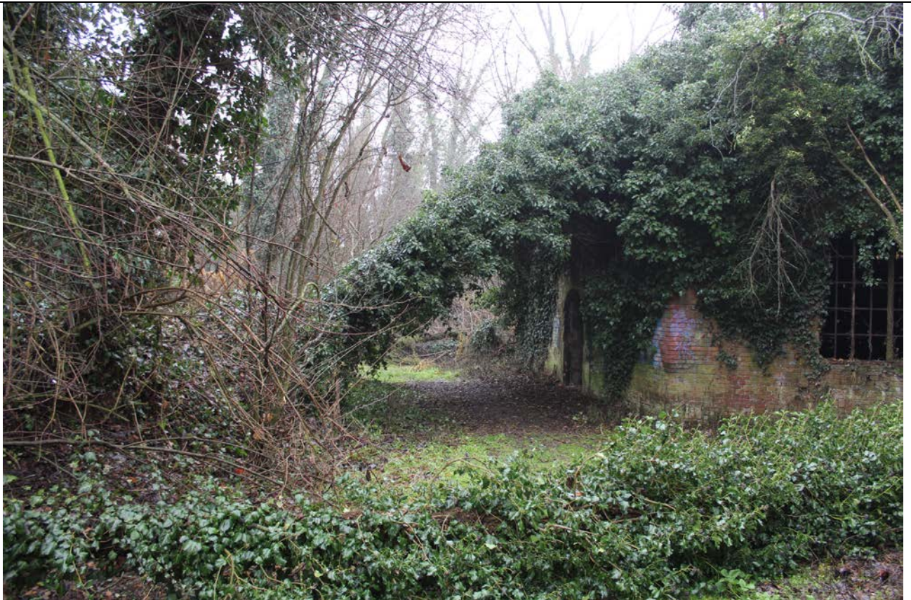
Dettaglio piantumazione abbattuta in area ingresso
