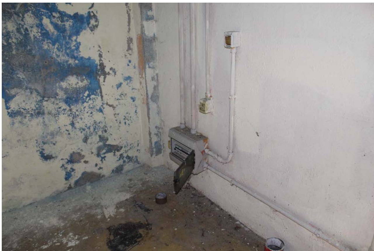
Elementi di impianto elettrico da rimuovere
