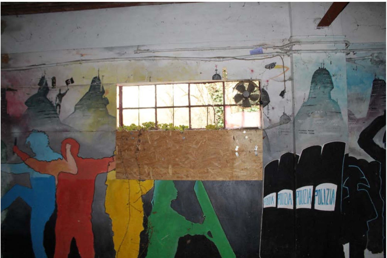
Finestratura immobile, vista interna
