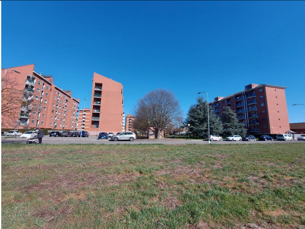
Vista area di intervento lato Nord, fronte R2
