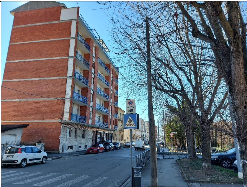
Vista su C.so Acqui, principale arteria stradale inserita nell'area di studio.
