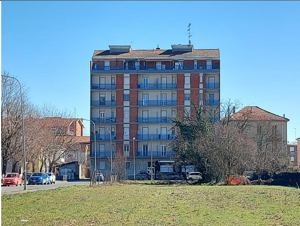
Vista dell'area di intervento in fregio a C.so Acqui, fronte R1.
