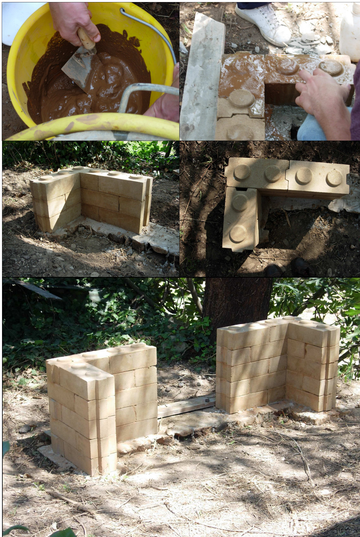
Riprese effettuate presso l'Impresa Edile Boschetto S.r.l., Cascinagrossa (Alessandria) e al Corso "Costruire con la terra cruda" (2007).
