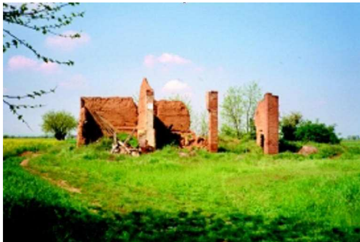
Cascinotto distrutto da un incendio e rimasto in balia degli agenti atmosferici.
