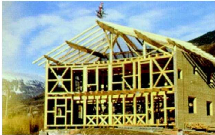
Trentino Alto-Adige: casa Jörg a Sluderno (BZ), i blocchi di terra cruda e la struttura portante in Fachwerk .
