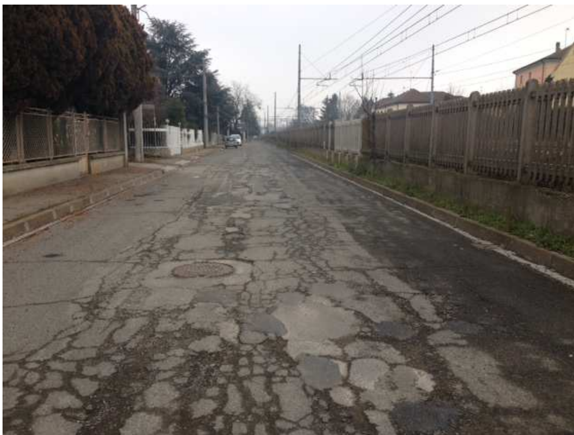
Via del Progresso - degrado totale della carreggiata
