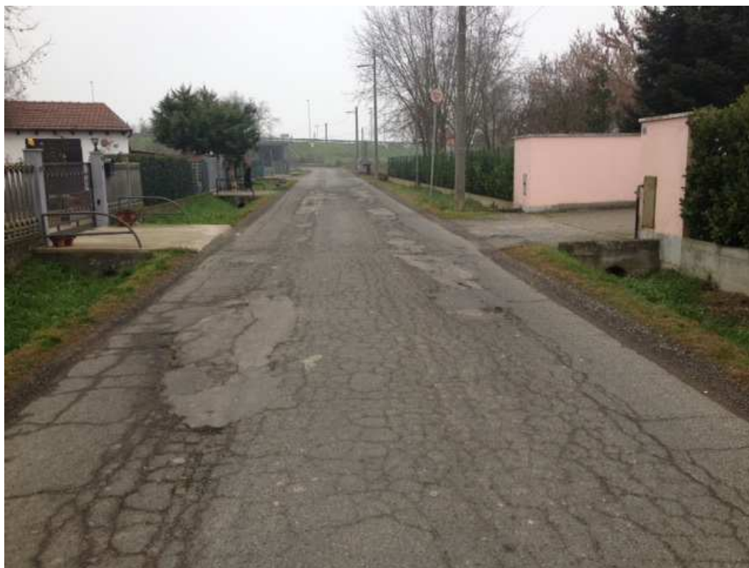
Via Remotti – marcato ammaloramento
