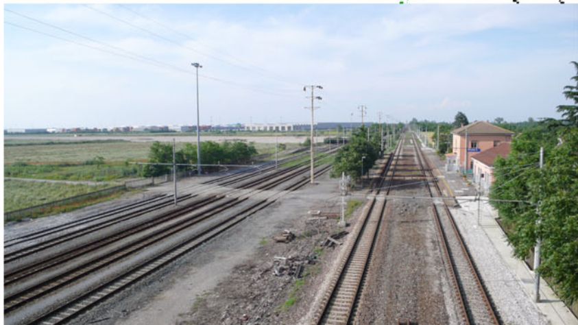
Veduta aerea dei binari in direzione Tortona
